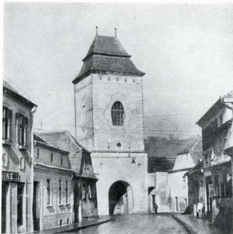
Fig. 4. — Turnul Steingässer din Mediaș, după restaurare.
