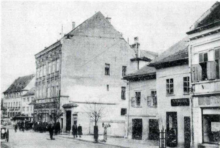
Fig. 22, 23. — Oficiul PTTR din Sighișoara: terenul pe care s-a aprobat amplasarea și construcția noii.
